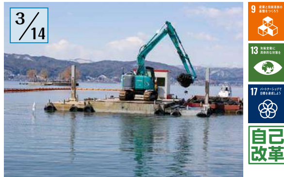
台船に載せた重機で湖底の泥をさう作業
